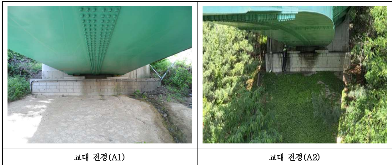
【사진 33.3.8】 교대 전경
