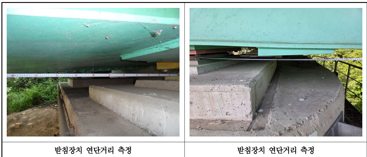
【사진 33.3.15】 교량받침장치 연단거리측정
