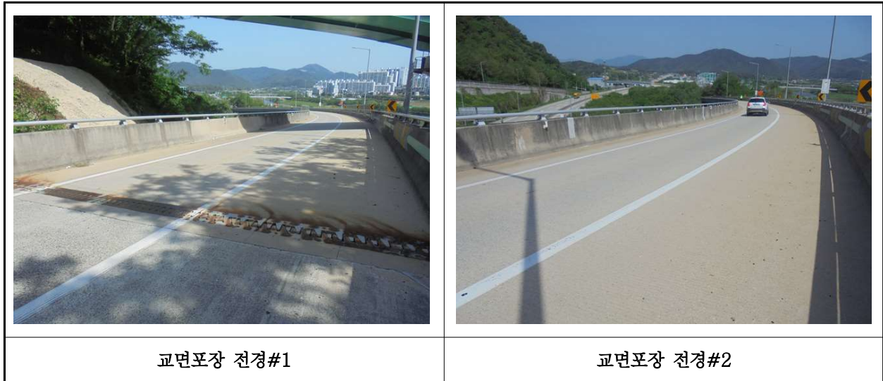
【사진 33.3.20】 교면포장 전경
